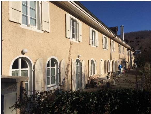
Mehrfamilienhäuser Süd-Westfassade, Obere Gasse 2-6
