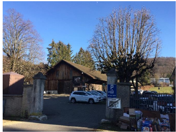
Einfahrt Obere Gasse, öffentliche Parkplätze, Lagerhalle Gemeinde
