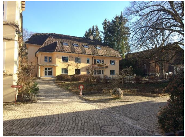
Wohnheim, Obere Gasse 10a
