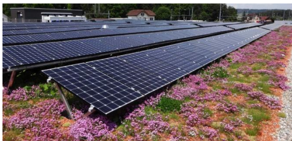
Abbildung 30: PV-Gründach als Alternative zum reinen PV-Dach 15
