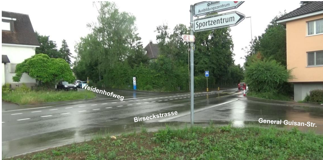
Abbildung 9: Knoten Birseckstr./General Guisan-Str./Weidenhofweg (Standbild Videoaufnahme)
