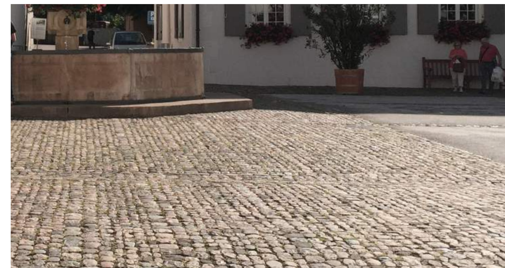
Materialisierung Dom: Ergänzung bestehendes Wackepflaster
