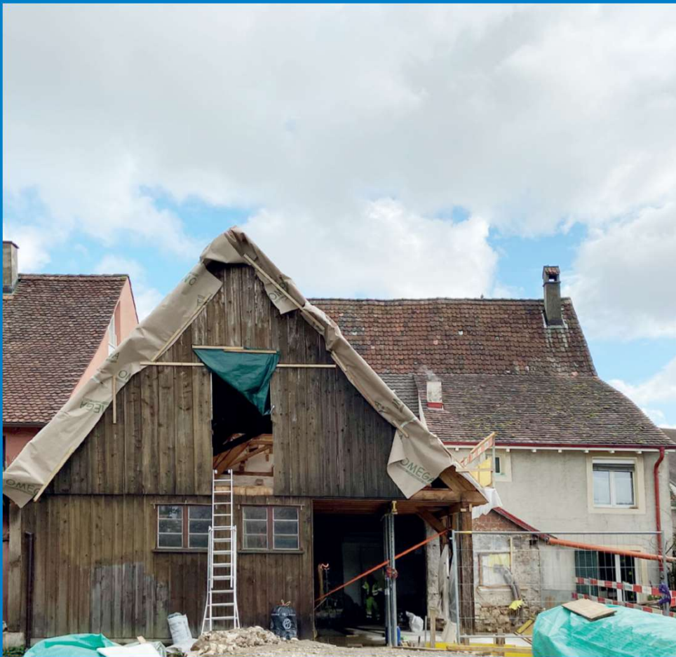
Dorfkern Muttenz, kommunal geschützte Baute
